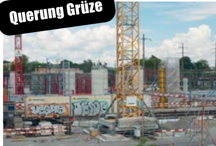
Baustelle Querung Grüze Foto: Raffaella Spataro
