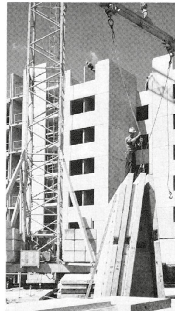
Montage der angelieferten Elemente (Quelle: GWG, Jahresbericht 1966)
